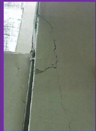
地震後、室内の床にタイルが数箇所割れて、また壁もひびができた。安全のため、タイルを外しました。
