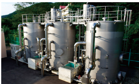
重力式急速ろ過装置
