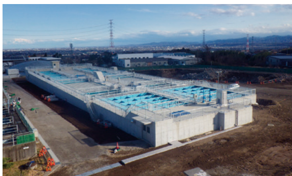
浄水処理施設
