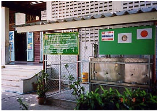
装置設置小屋
