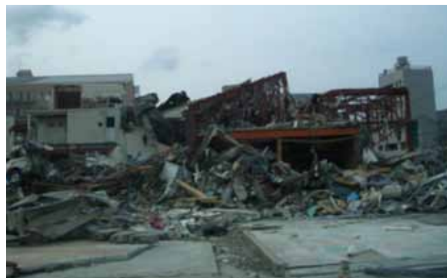
鉄骨だけ残された、がれきの山
